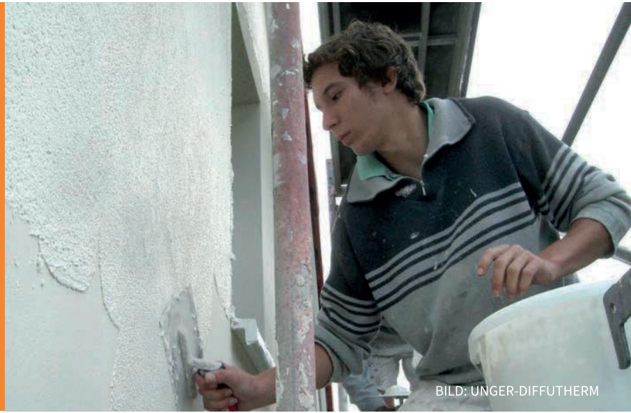
Anbringen und strukturieren von Putz auf Holzfaser-WDVS
