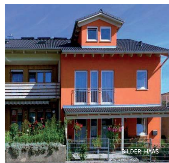
Nach dem Anbau
