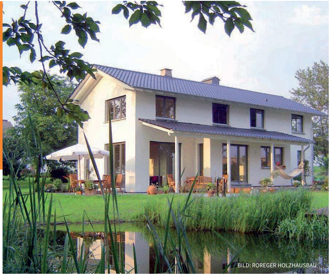
Holzrahmenbauweise mit Putzfassade
