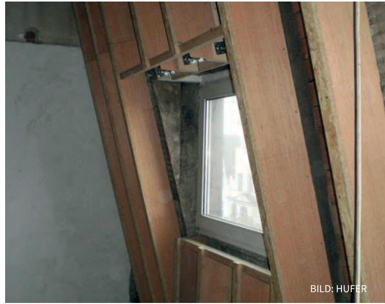
Sparrenexpander ermöglichen den Einbau größerer Dämmdicken und dienen dem Ausgleich von Unebenheiten der Bestandskonstruktion.
