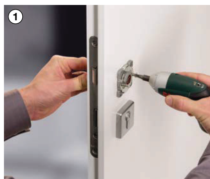
1 Unterkonstruktion aufstecken und festschrauben
