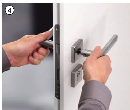
4 Griffe zusammenstecken und Innensechskant-Schraube festziehen
