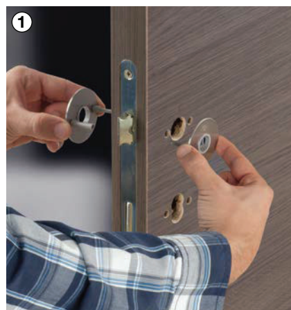
Griffrosetten aufstecken
